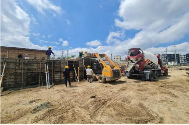
Suministro, transporte y colocación de concreto de 4.000 PSI para vástago (costado occidental) de muro de contención perimetral de la pista de competencia.
