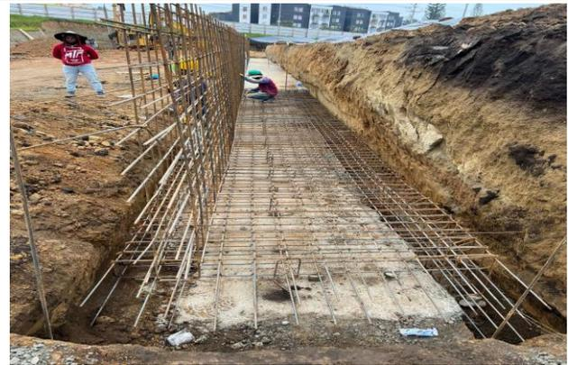
Suministro, disposición, instalación y armado de acero de refuerzo para zarpa y vástago de muro de contención perimetral de la pista de competencia.
