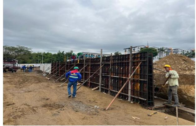
Encofrado en formaleta metálica para vástago (costado occidental) de muro de contención perimetral de la pista de competencia.
