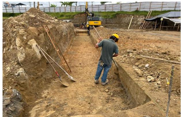
Excavación y nivelación manual para conformación de la subrasante de la zarpa del muro de contención perimetral de la pista de competencia.
