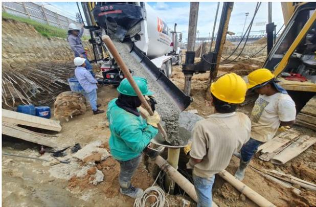
Suministro, transporte y colocación de concreto tremie con aditivos plastificantes de 4.000 PSI para pilotes pre-excavados y fundidos in situ de diámetros 1,00 m y 0,80 m.
