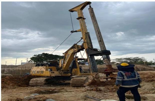
Excavación mecánica para pilotes y retiro de material sobrante.
