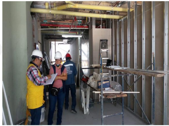
Ilustración 44 Remodelación del Hospital San Juan de Dios Mpio de Armenia.
