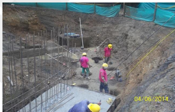
Ilustración 7 Proceso constructivo muro Municipio de Buenavista.
