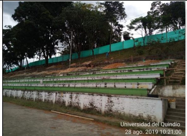
Ilustración 51 Excavación de pilotes para cubierta, Universidad del Quindío.
