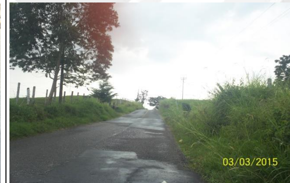
Ilustración 12 reparcho punto crítico circasia-Montenegro.
