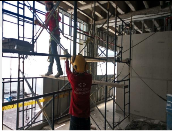
Ilustración 46 Remodelación del Hospital San Juan de Dios Mpio de Armenia.
