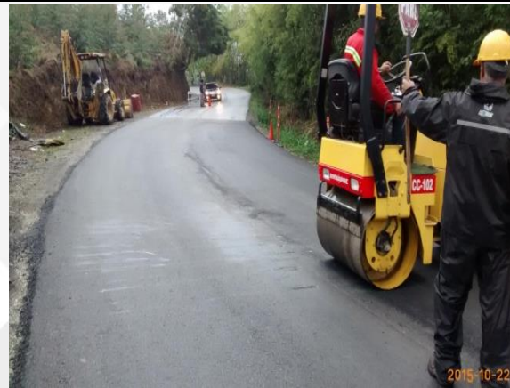
Ilustración 22 Tramo Salento: reparación tramo, maquinaria empleada y medidas de prevención - señalización.
