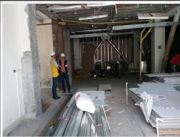
Ilustración 47 Remodelación del Hospital San Juan de Dios Mpio de Armenia.
