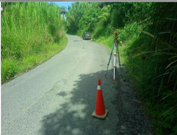
Ilustración 54 Estado actual de la vía 3, Circasia - Montenegro.
