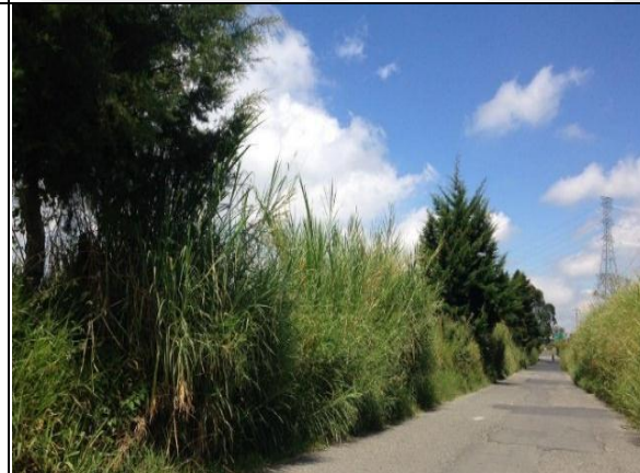
Ilustración 55 Estado actual de la vía 4, Circasia - Montenegro.
