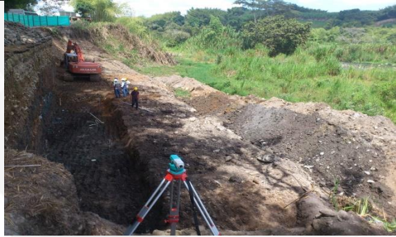
Ilustración 2 Localización y Replanteo para la construcción.
