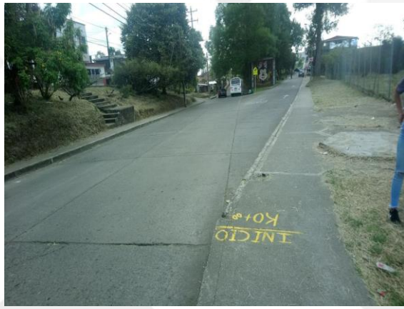
Ilustración 52 Estado actual de la vía 1, Circasia - Montenegro.
