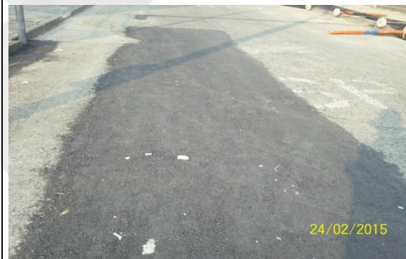
Ilustración 11 Reparcho realizado en la vía urbana del barrio Uribe Armenia.
