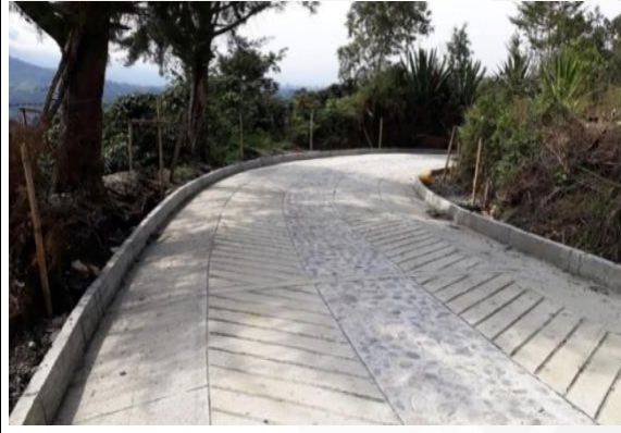
Ilustración 37 Placa huella tramo 1 municipio de Salento.
