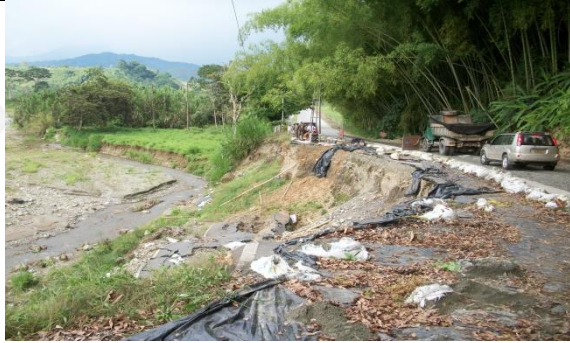
Ilustración 1 Estado de la vía Rio Verde - Barragán.
