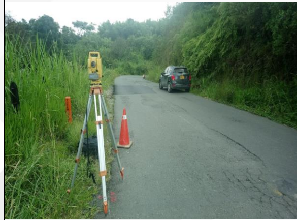
Ilustración 53 Estado actual de la vía 2, Circasia - Montenegro.
