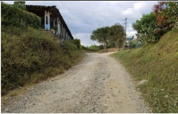
Ilustración 33 Tramo 2 - Estado Actual de la Vía, vereda Las Pavas Mpio de Filandia.
