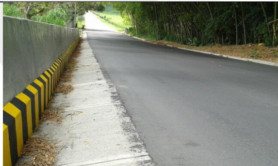
Ilustración 4 Rehabilitación vía terminada.
