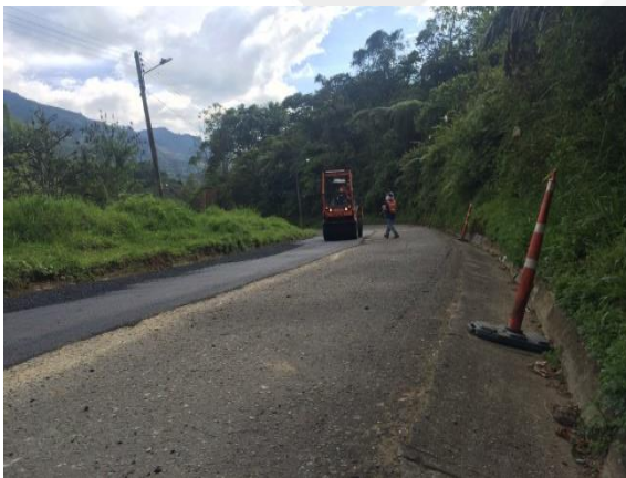
Ilustración 21 Tramo pijao: proceso constructivo de reparación superficie compactación.
