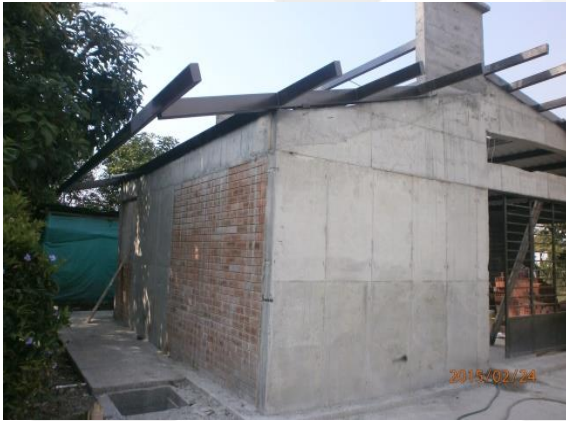
Ilustración 17 instalación de cerchas en cubierta.
