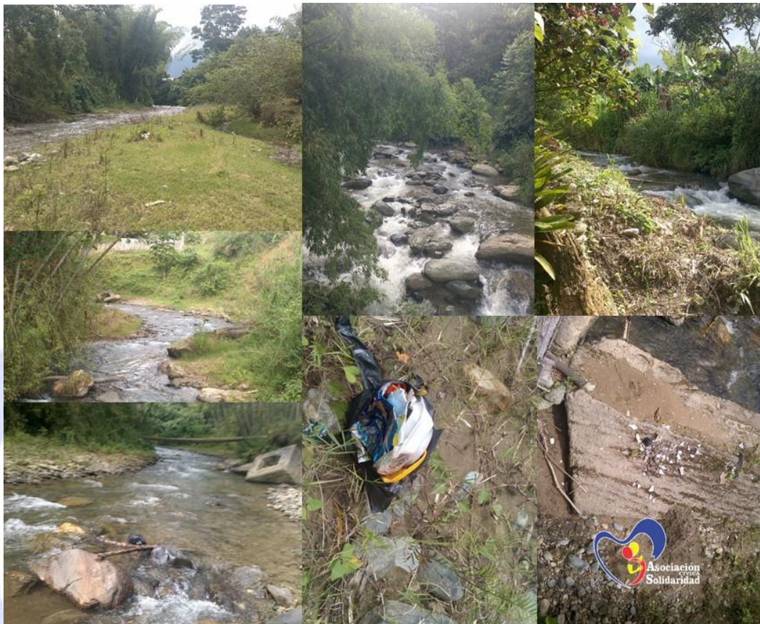
Figura 13. Registro fotográfico de inspección de platas y curso de agua en los ríos circundantes del municipio de Génova, Quindío.
