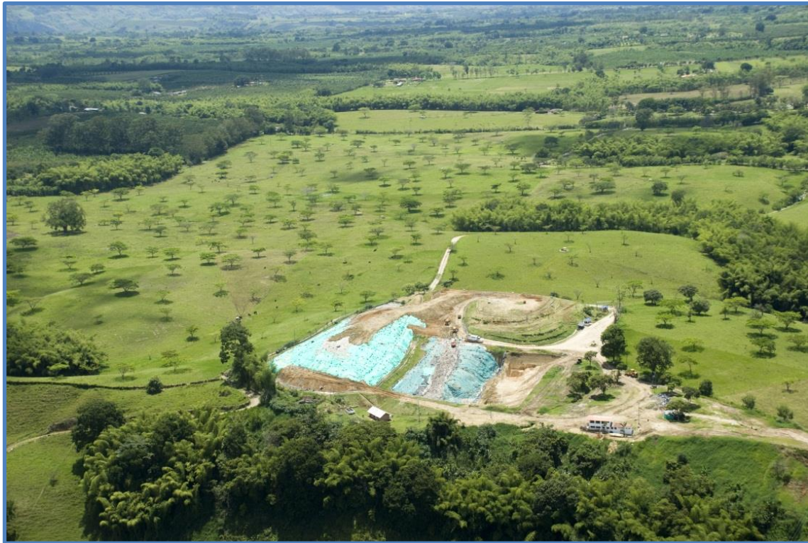
Ilustración 12. Fotografía relleno sanitario Andalucía- Cafeaseo del Quindío
