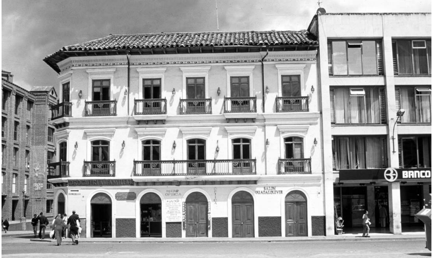
Edificación localizada en el marco de la Plaza de Nariño. Pasto, Nariño. Foto: Alberto Saldarriaga.
