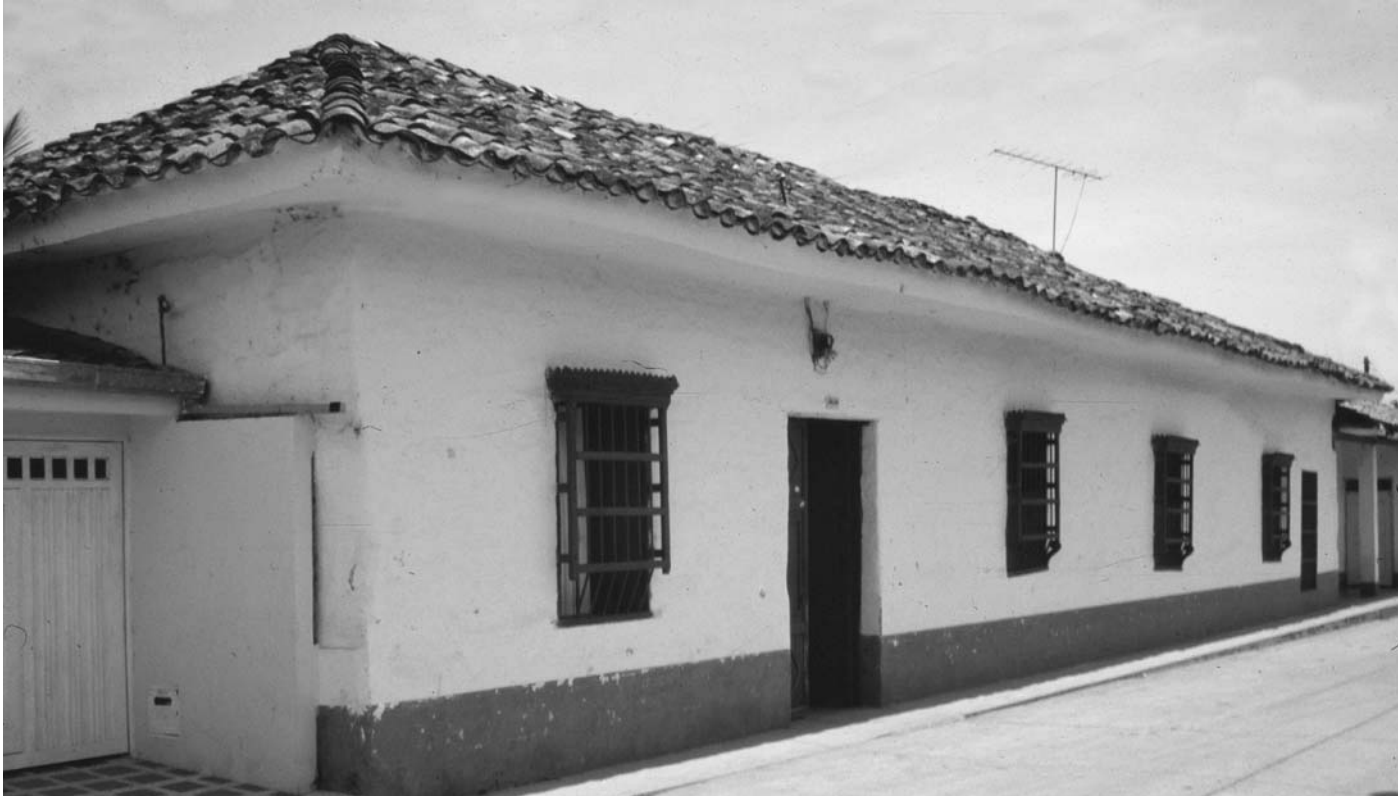
Vivienda. Caloto, Cauca. Foto: Alberto Saldarriaga.
