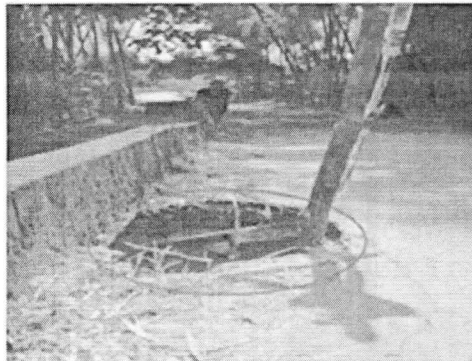
Lo que se marcaba como un fallo en losa hace dos meses, en mayo ya hay pérdida de 1,20x0,70m de losa
