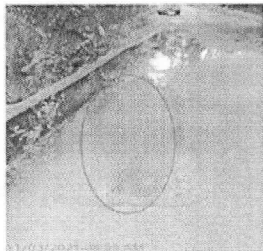
Lo que se marcaba como un fallo en losa hace dos meses, en mayo ya hay pérdida de 1,20x0,70m de losa
