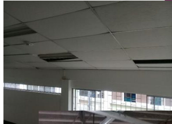
Desmante de cielo falso
