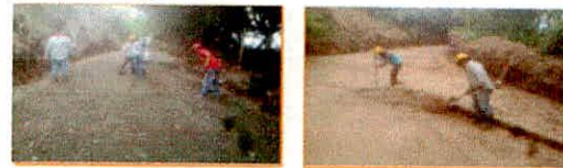
Inicio de obra
