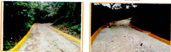
Final de obra
