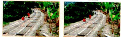
Inicio de obra
