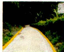
Final de obra
