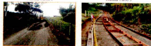
Inicio de obra
