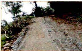
Inicio de obra
