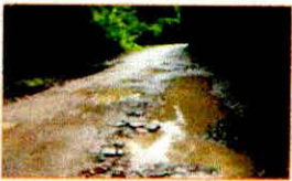
Inicio de obra
