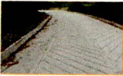
Final de obra
